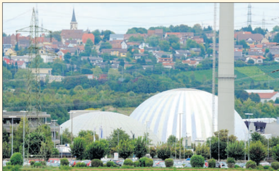
Der Hybridkühlturm des Kernkraftwerks Neckarwestheim (EnBW).
